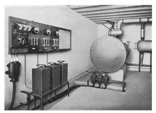
Wollweberei Rüti bei Lintthal. Elektrische Niederdruck-Dampfheizung Drehstrom 500 Volt, mit der die gesamte industrielle Anlage geheizt wird. Verwendung billiger Abfallkraft Nachtstrom. Gebrüder Sulzer Akt.-Ges. Abt. Zentralheizungen, Winterthur
