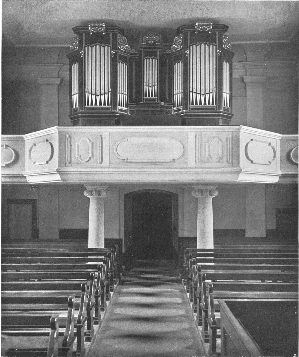
Architekt J. E. Meier-Braun B. S. A., Basel. Orgel und Emporen-Einbau in der Kirche Holderbank. Ausführung: Schmid, Fischer & Cie., Baugeschäft, Wildegg; Orgelwerk u. Gehäuse Goll & Cie., Orgelbau, Luzern; Vergoldungen R. Messmer, Atelier für kirchliche Kunst, Basel; Schnitzereien E. Fuchs, Bildhauer, Basel
