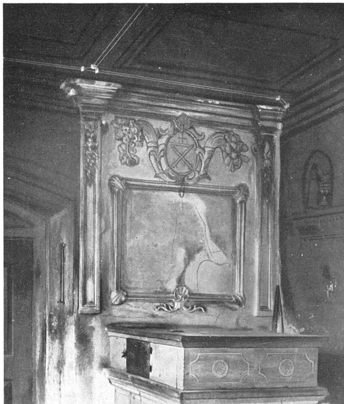
Oben: Altdorf, Haus des Landammanns Dominik Epp Rest eines Kamin- aufbaues im 1. Stock Decken und Wände sind im Grund grün gestrichen Verzierungen in Gelb, Rot und Blau Leisten vergoldet Südwestliche Eck- stube im 1. Stock
