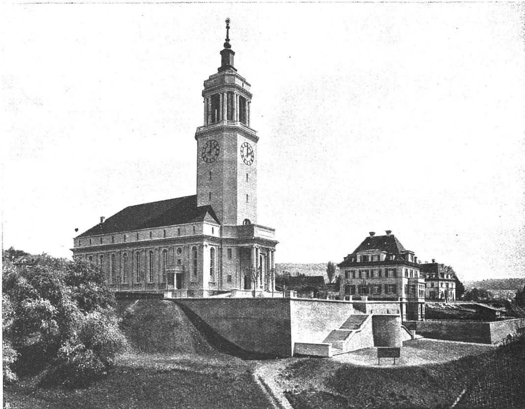
NEUE KIRCHE UND PFARRHAUS IN ZÜRICH-FLUNTERN
