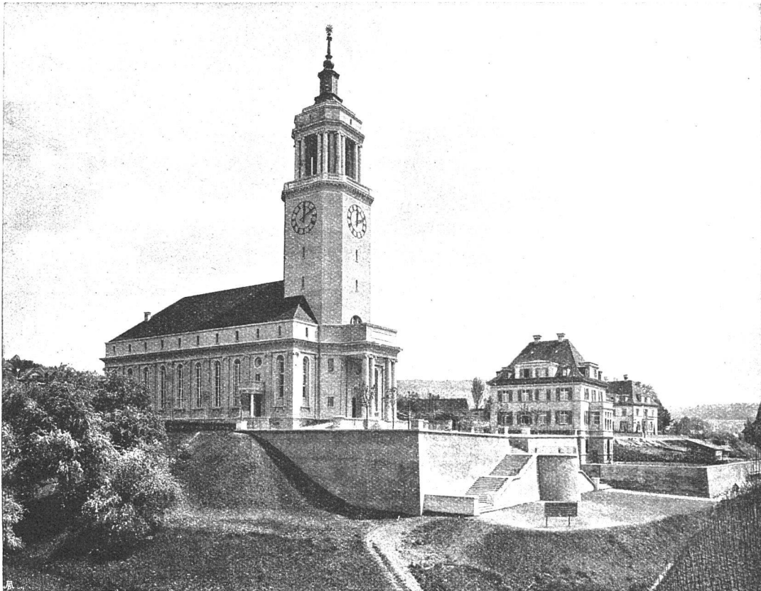
NEUE KIRCHE UND PFARRHAUS IN ZÜRICH-FLUNTERN
