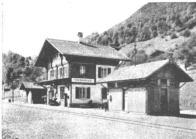
STATION DER BRIENZERSEEBAHN, ETERNIT-DOPPELDACH, KUPFERBRAUN
