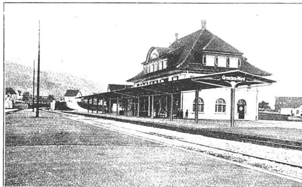
BAHNHOF GRENCHEM NORD
