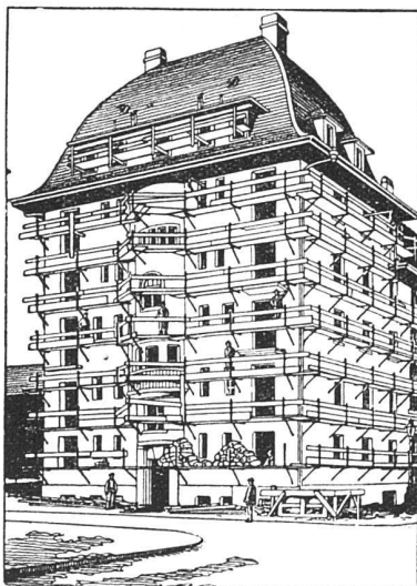
Ansicht eines eingerüsteten Hauses
