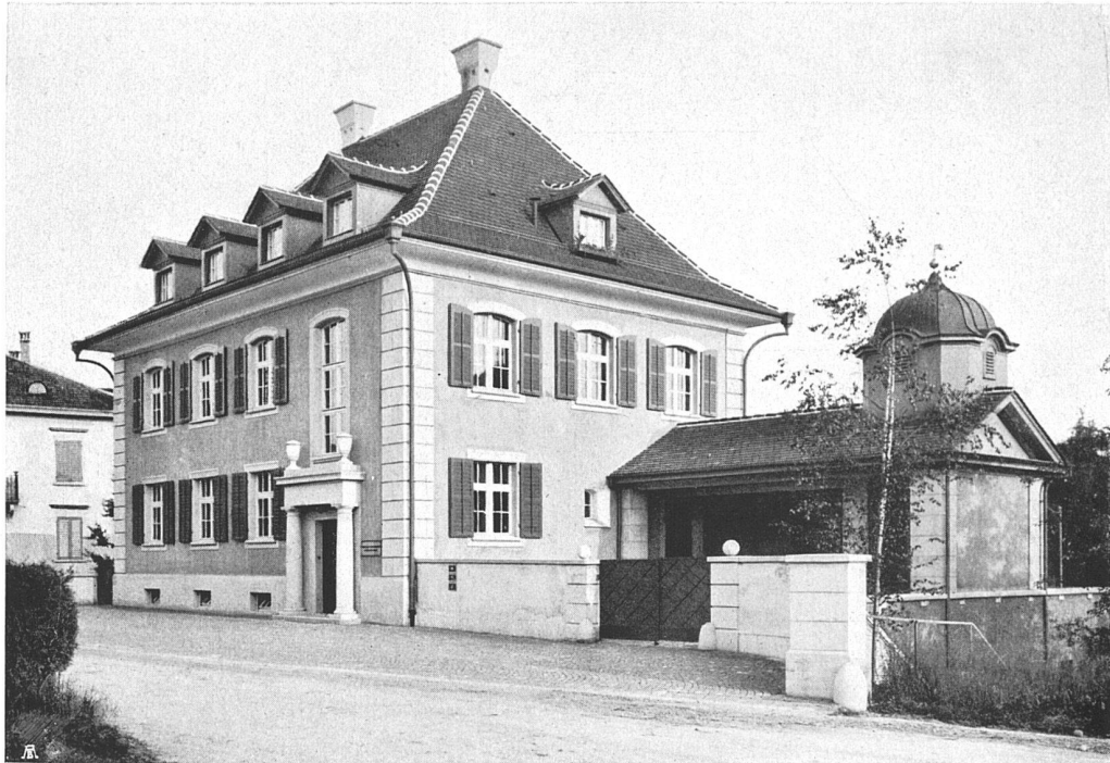
Geschäftshaus-Neubau der Firma Hultegger, Steiner & Ehram, Stäfa
