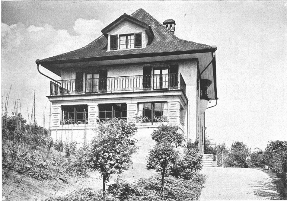
Architekten B. S. A. Kölla & Roth in Wädenswil
