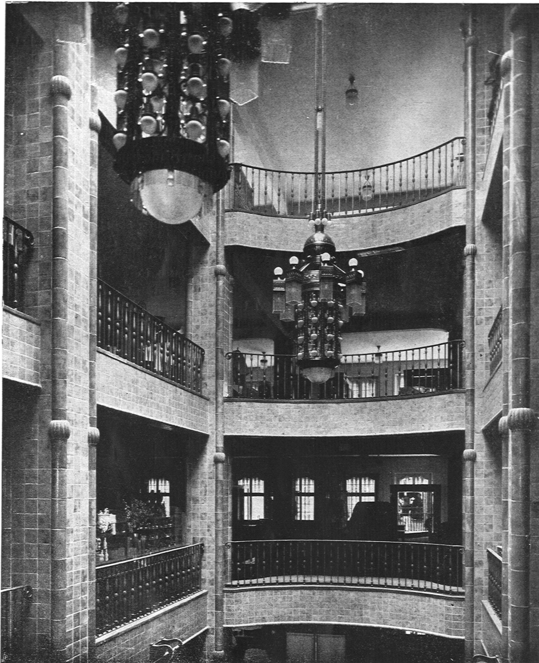
DAS HAUS DER SCHMIEDENZUNFT IN BERN. PFEILER UND WÄNDE IN MUTZKERAMIK. LICHTHOF IM WARENHAUS GROSCH & GREIFF
