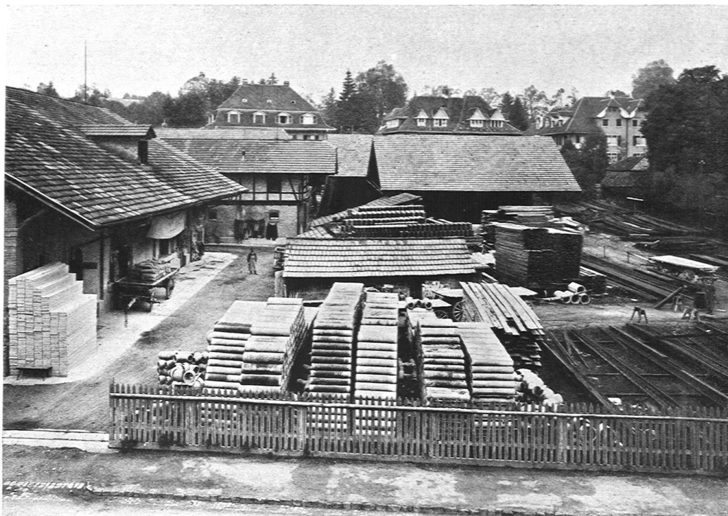
LAGER AN ZEMENTWAREN, BAUEISEN UND GUSSWAREN DER BAUKONTOR BERN A.-G. AN DER EFFINGERSTRASSE IN BERN
