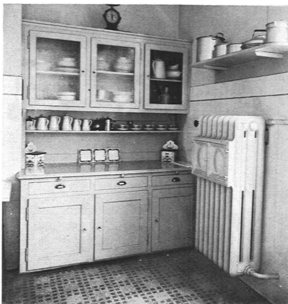
KÜCHE: WANDBELAG IN WEISS GLASIERTEN WANDPLATTEN VON SOMAG, MEISSEN. BODEN IN MARMORMOSAİK-PLATTEN VON BALDEGG. BAD: WANDBELAG IN MAJOLIKA-WAND- PLATTEN GELB GLASIERT VON SOMAG, MEISSEN
