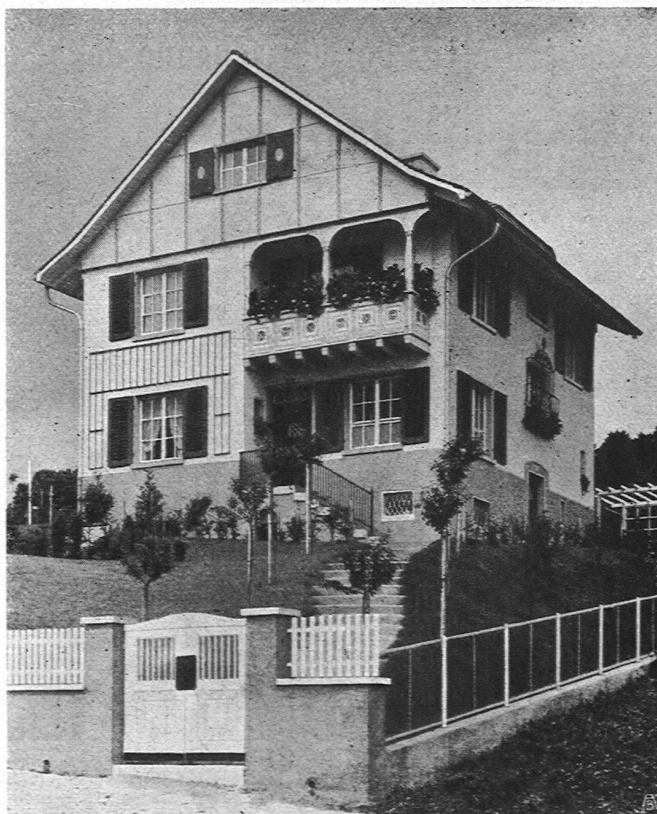
Haus mit Giebel- verkleidung aus Eternit
