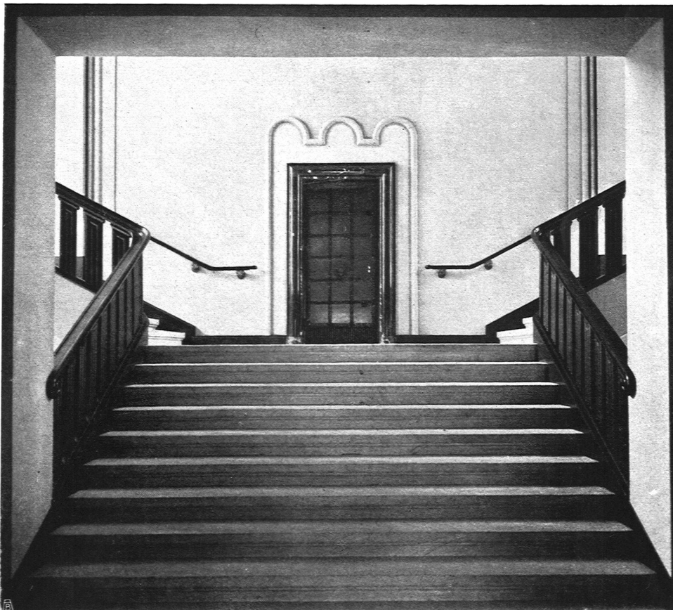
Verbindungstüre zwischen Verhöramt und Zellenbau
