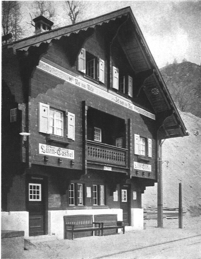
Stationsgebäude Lünen-Castiel Geleiseite
