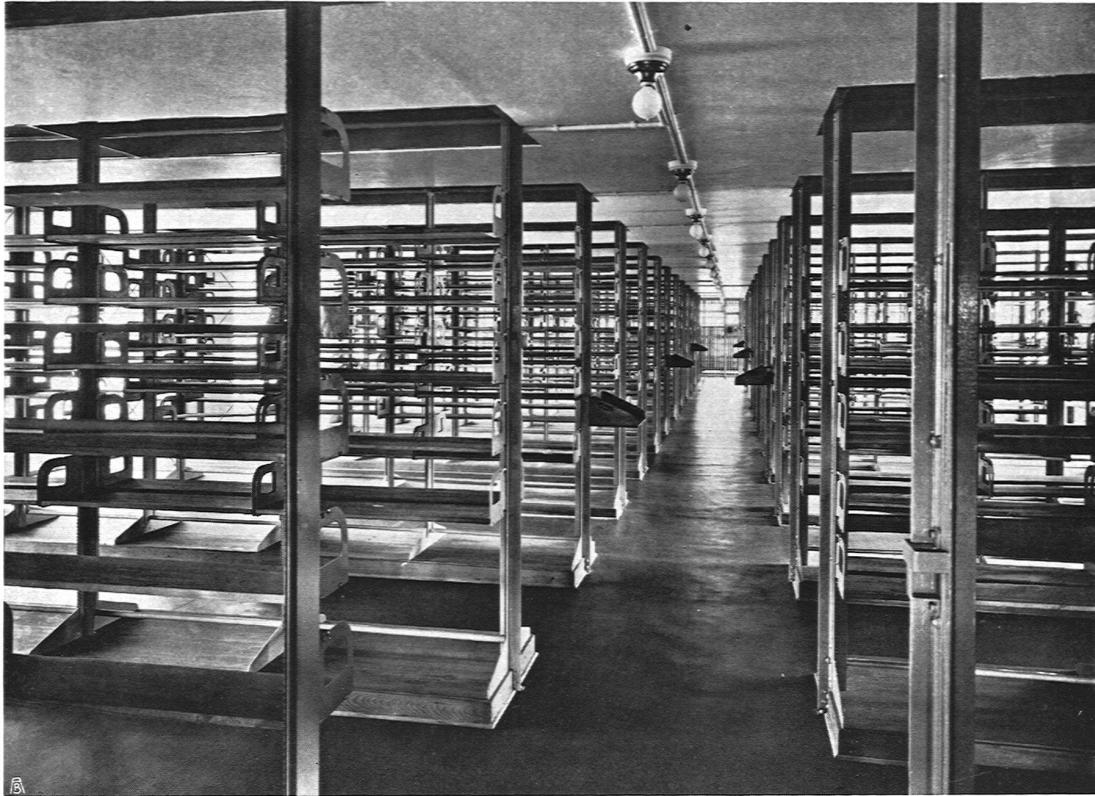
Museum und Bibliothekgebäude Winterthur. Blick in das Büchermagazin (System Geilinger)
