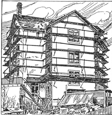
Ganz eingerüstetes Haus
