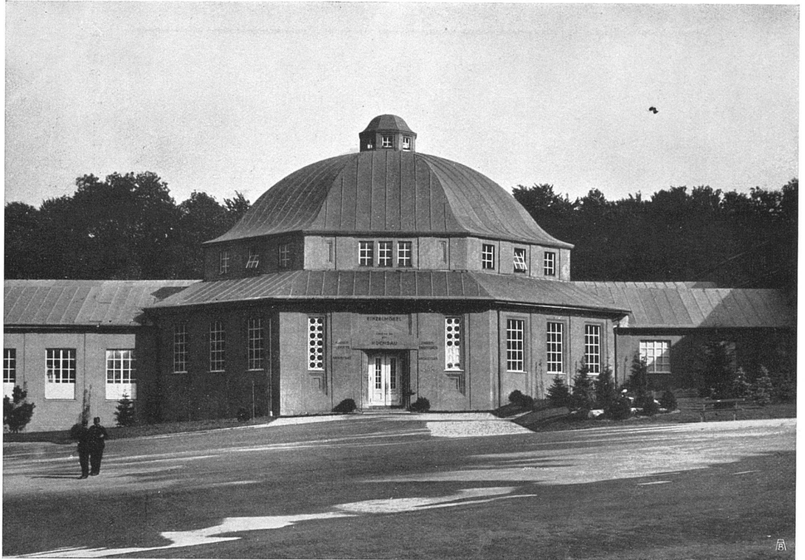
Pavillon für Hochbau
