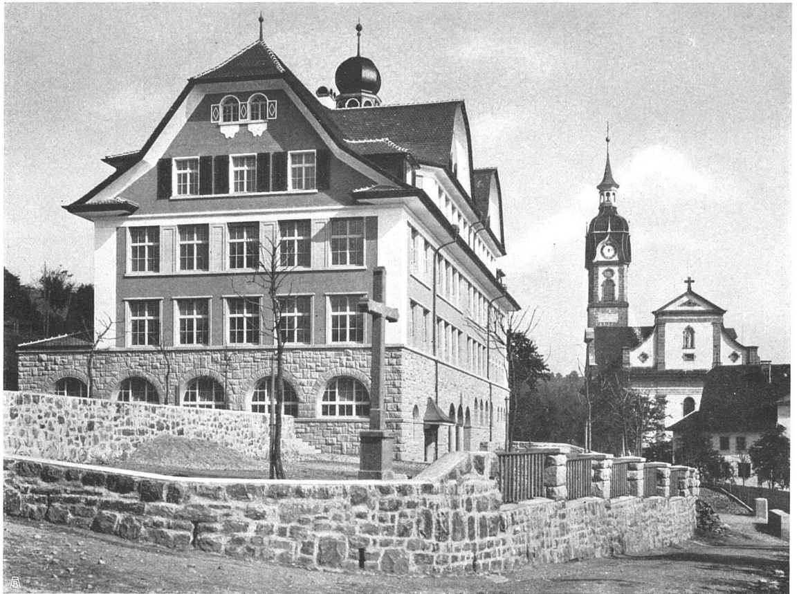
Schulhaus Ruswil Gesamtansicht, seitlich
