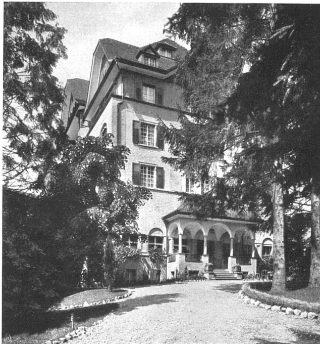
Parkhotel Weggis Eingang
