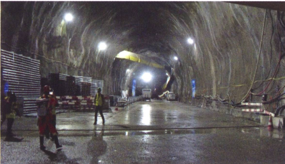
Fig. 4: Blick in den Eingangsbereich der zweiten Tunnelröhre.
