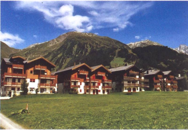
Fig. 5: Oberwald/VS: Diese und auch andere Gebäude sind an die «kalte Fernwärme» aus dem Furka-Tunnel angeschlossen.
