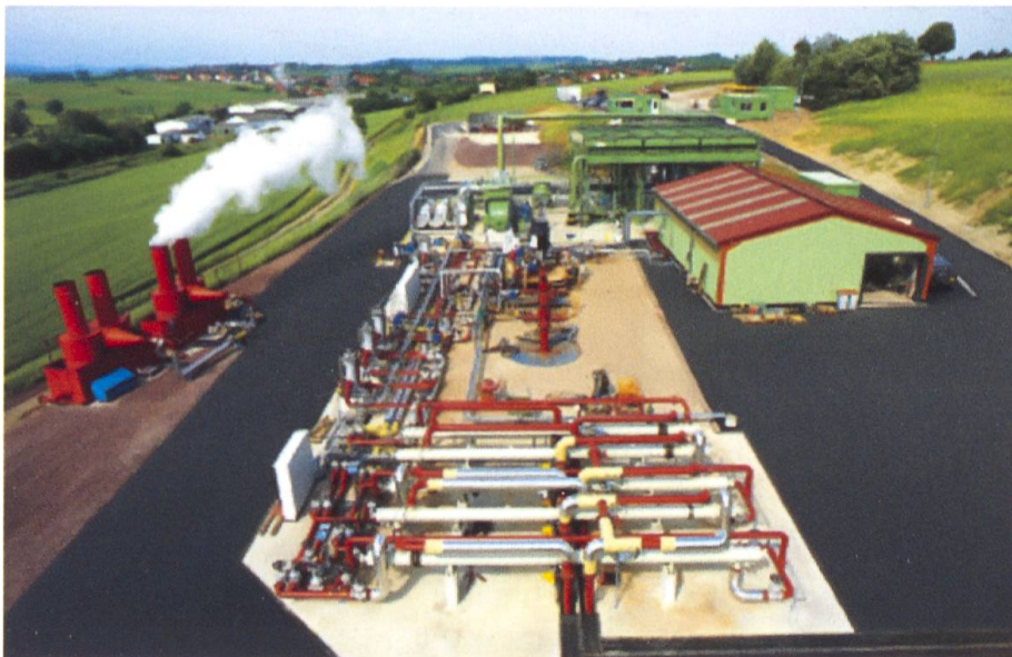
Fig. 10: Die Europäische HDR-Anlage Soultz-sous-Forêts; 1.0 MWe installierte Kapazität (1998).
