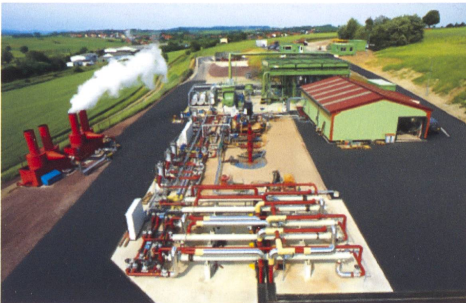
Fig. 10: Die Europäische HDR-Anlage Soultz-sous-Forêts; 1.0 MWe installierte Kapazität (1998).
