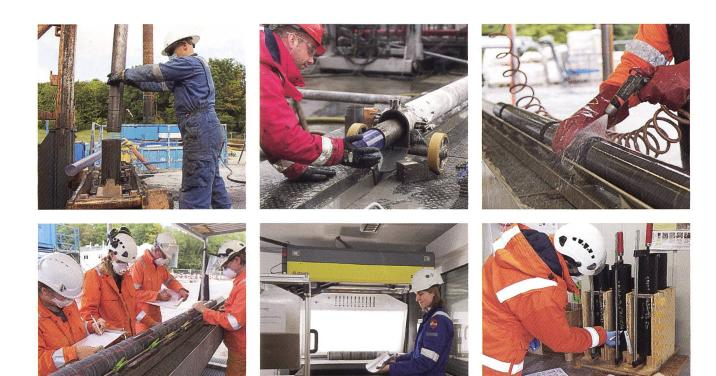
Fig. 4: Vor-Ort Arbeitsabläufe für Bohrkerne im Rahmen der Tiefbohrkampagne. Jeweils von links nach rechts; oben: Entnahme Innenkernrohr – Entnahme Bohrkern mit schützendem Plastikrohr – Reinigung; unten: Erste Bohrkern-Dokumentation – Bohrkern-Scan (vgl. Fig. 5) – Beprobung. Fotos: © Comet Photoshopping GmbH, Dieter Enz.
