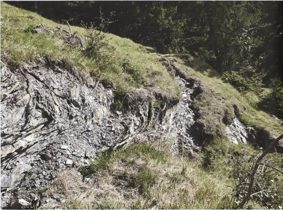
Fig. 2: Anrisse im Gelände und verrutschte Flysch-Kompartimente.
