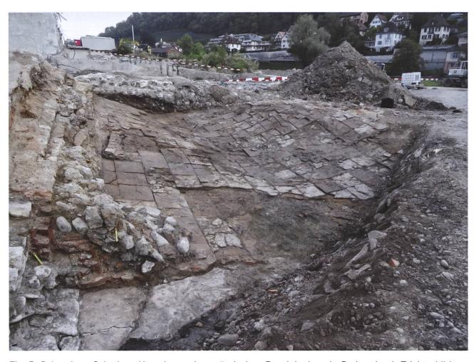
Fig. 5: Subrosions-Schaden: Absenkung eines römischen Bassinbodens in Baden durch Trichterbildung infolge von Gipskarst. Lokalität: früheres Badehotel "Staadhof". Unter den Platten war römischer Beton, darunter Keuperfels. Das Bassin wurde im 3. Jahrhundert aufgegeben.
