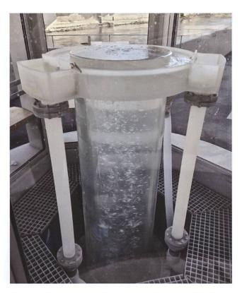
Fig. 4: Fassung der Limmatquelle; mit 150 l/min gehört sie zu den ertragreichen Thermen. Der Quellaufstieg wird mit einem transparenten Aufstiegsrohr sichtbar gemacht. Darin sieht man auch deutlich die aufsteigenden Gasblasen. Zuoberst ist kranzförmig ein Quellwasserteiler, im Hintergrund die Limmat (vgl. auch Mühlberg 1909).
