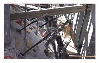
Fig. 5: Blick während der Spannarbeiten in den Ankerkeller mit den im Fundamentblock eingebauten Ankern und Extensometern.
