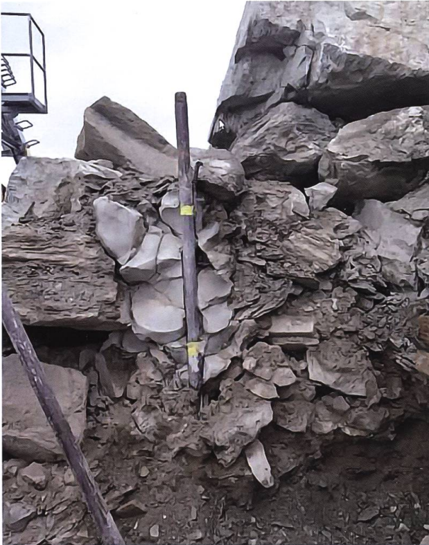
Fig. 21: Injektionssäule (hellgrau) in den Hohlräumen des Blockschuttes am Rand der Aushubkante.
