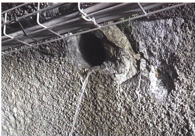
Fig. 10: Wasserführende Entlastungsbohrung im Spritzbetongewölbe des Aletschanges.
