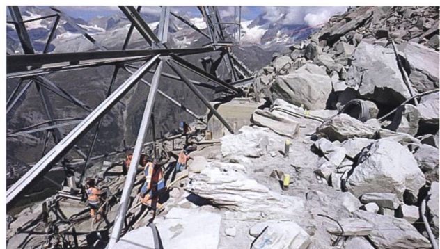
Fig. 18: Ansicht der Baustelle mit Mastfundament und Bohrungen im Vordergrund.
