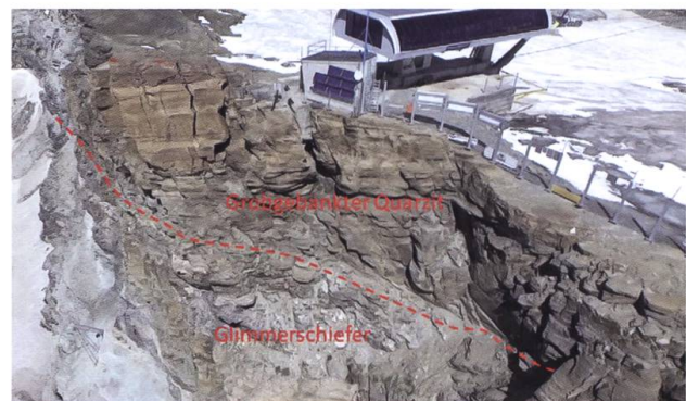
Fig. 3: Ansicht der Station von Süden mit den zerklüfteten und aufgelockerten Felszonen.
