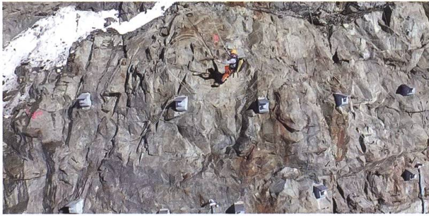
Fig. 13: Überprüfung der Ankerköpfe durch den Geologen.
