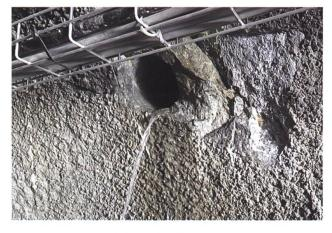
Fig. 10: Wasserführende Entlastungsbohrung im Spritzbetongewölbe des Aletschausganges.
