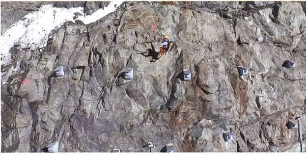
Fig. 13: Überprüfung der Ankerköpfe durch den Geologen.
