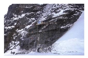
Fig. 11: Winterbaustelle oberhalb Aletschausgang zur Erstellung der permanenten Verankerungen.
