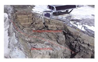
Fig. 3: Ansicht der Station von Süden mit den zerklüfteten und aufgelockerten Felszonen.
