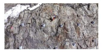
Fig. 13: Überprüfung der Ankerköpfe durch den Geologen.
