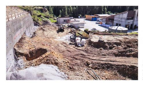
Fig. 4: Lage des freigelegten Karsthohlraumes an der hangseitigen Baugrubenwand (Bild Th. Rüegg, 31.07.2017).
