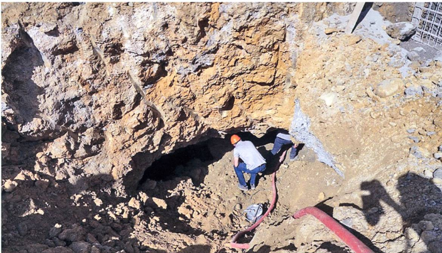
Fig. 5: Freigelegter Zugang zum Karsthohlraum (Bild Th. Rüegg, 04.08.2017).
