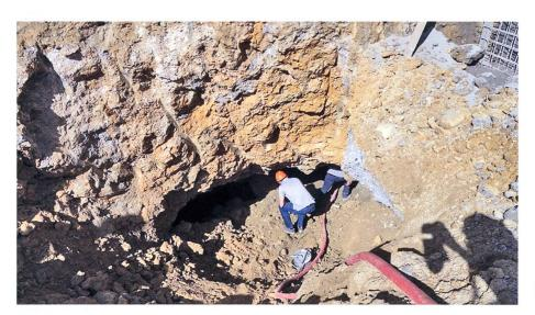
Fig. 5: Freigelegter Zugang zum Karsthohlraum (Bild Th. Rüegg, 04.08.2017).
