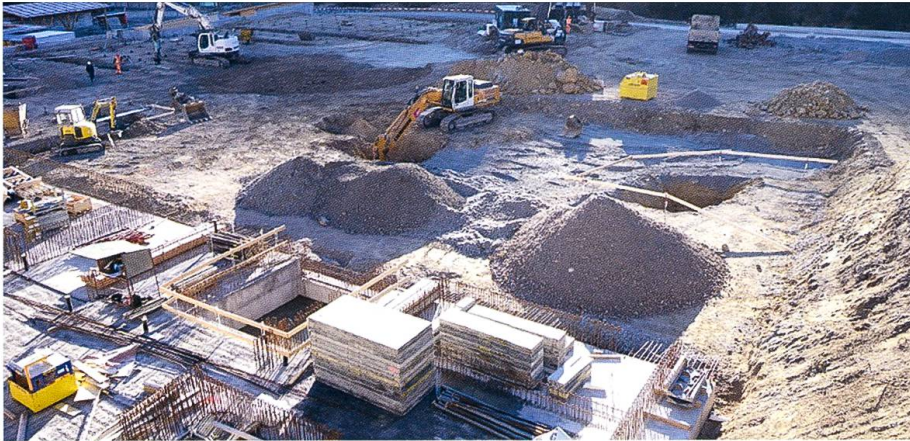
Fig. 12: Freigelegte Karsthohlräume in der zweiten Untersuchungsetappe. Davor der angelieferte Kiessand zur Verfüllung und Verdichtung (Bild Th. Rüegg, 03.11.2017).
