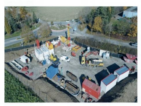
Fig. 1: Bohrplatz mit Bohrgerät und den zugehörenden Installationen und Behausungen (Bild: geothermie.ch).
