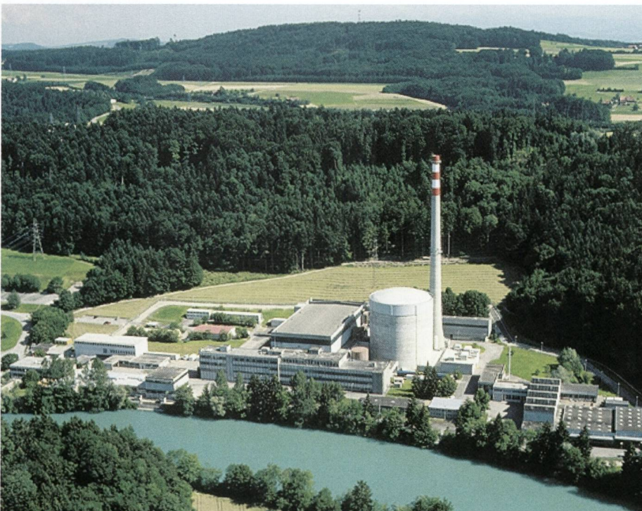
Fig. 1: Luftaufnahme des Kernkraftwerkes mit der Aare in Vordergrund.
