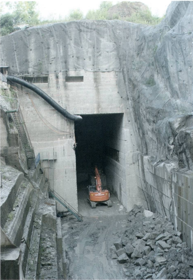
Fig. 9: Blick Richtung Westen mit dem ca. 13.5 m hohen Portal zum bergmännischen Vortrieb, der gegen Steinfall gesicherten Nord- und Westwand sowie der Lutte zur Belüftung der Kaverne.
