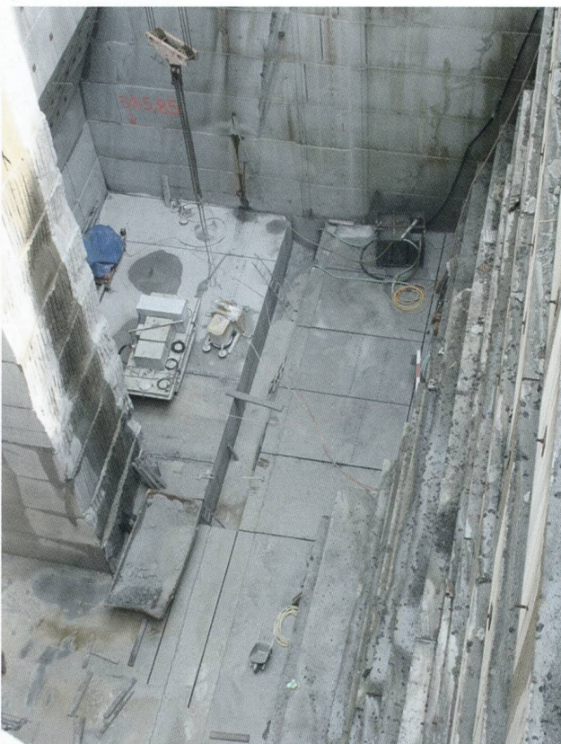
Fig. 5: Blick in die Sohle von Schacht 5/6 mit unterschrittener Nord- (links) und abgetreppter Südwand (rechts) sowie Stütze aus gewachsenem Fels.
