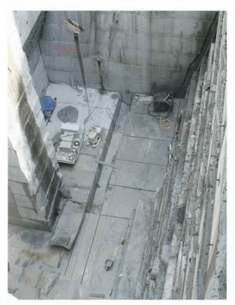
Fig. 5: Blick in die Sohle von Schacht 5/6 mit unterschnittener Nord- (links) und abgetreppter Südwand (rechts) sowie Stütze aus gewachsenem Fels.
