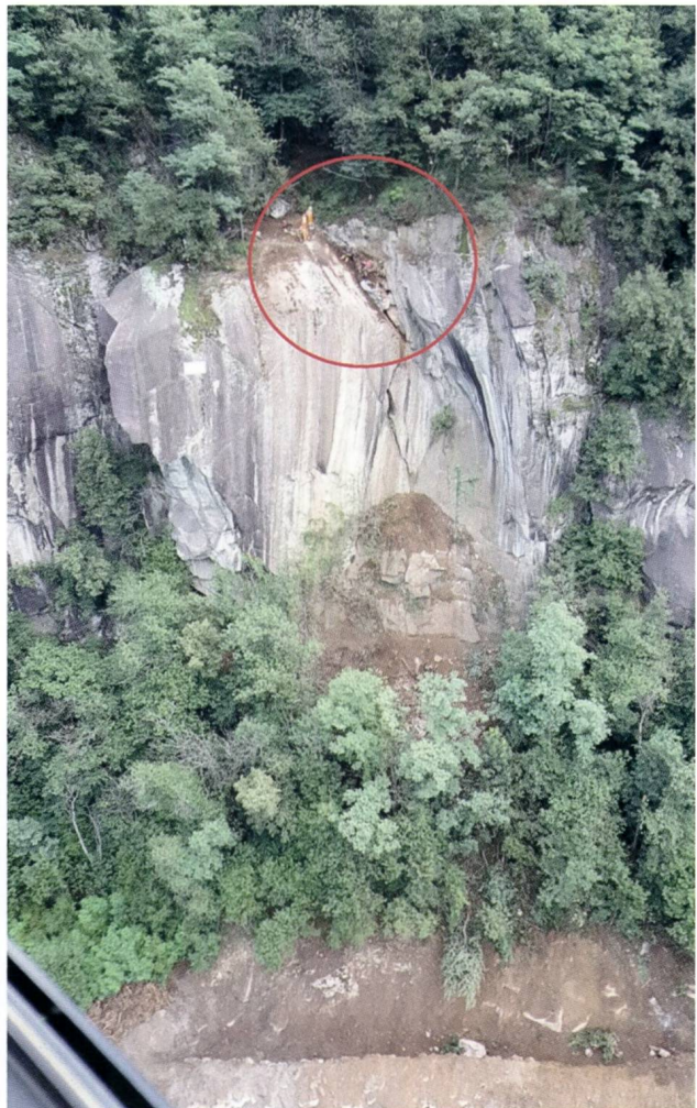
Fig. 9: Blick aus der Luft auf die Sprengstelle (roter Kreis), die Sturzbahn und den provisorischen Schutzdamm. Im Schutzdamm liegen einzelne grössere Sturzblöcke.
