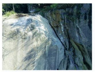
Fig. 10: Blick auf die Sprengstelle nach der Felsreinigung und auf den mit Felsnägeln gesicherten Felspfeiler rechts davon.
