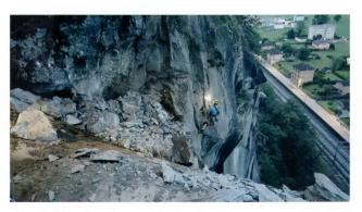
Fig. 8: Unmittelbar nach der Sprengung vom 23. Juli 2017 am frühen Morgen erfolgte die Felsreinigung. Rechts im Bild die SBB-Linie.
