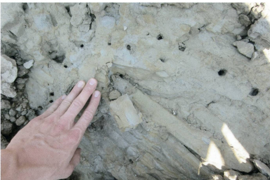
Fig. 1: Bergwasser- oder Hangwasserzutritte hinterlassen Löcher auf der Gleitfläche im Anrissgebiet (verwitterte Mergel) der Hangmure (Schwellbrunn; Foto: B. Stricker).
