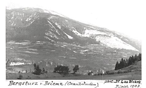
Fig. 5: Die ab 1878 aktive Felssackung Igl Rutsch, deren Schuttkegel sich am östlichen Dorfrand bis über die untersten Häuser erstreckte und heute noch mit 100 mm/Jahr aktiv ist [9].
