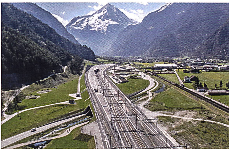
Bild 1: Nordportal Gotthard-Basistunnel in Erstfeld, Alp-Transit Gotthard AG.
