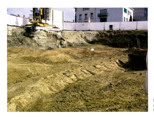
Fig. 9: Surface du toit de la molasse marneuse au terme des excavations.
