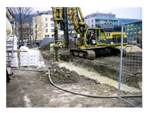
Fig. 5: Exécution de l'enceinte de confinement selon la technique «Mixed In Place».
