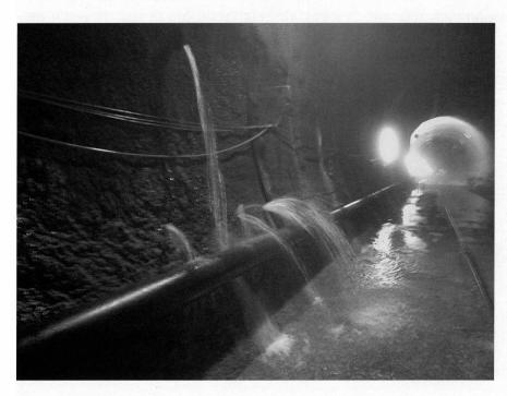
Fig. 1: Ergiebige Bergwasserzutritte in der Weströhre im Bereich des Querschlages 16 während der Schneeschmelze. Bild vom 21.6.2010 bei km 204.735, Blick Richtung Süden.
