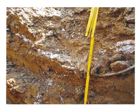
Fig. 12: Oberer Injektionsbereich im Tegel.
