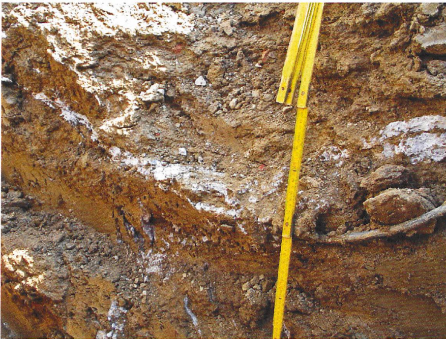
Fig. 12: Oberer Injektionsbereich im Tegel.
