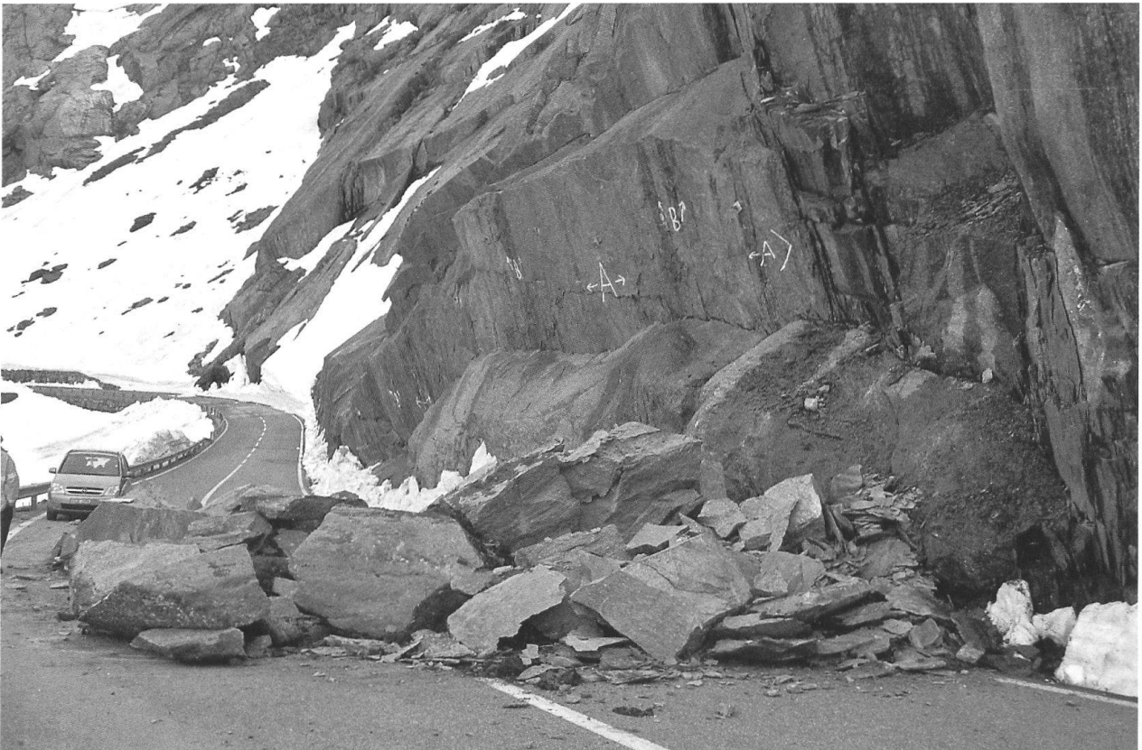
Fig. 2: Beispiel eines Sturzereignisses im Frühling mit einer grösseren Anzahl von kleinen Blöcken: An der Grimselpassstrasse (Kanton Bern) stürzten im Mai 2007 nach einem kalten Winter rund 30 m 3 Fels auf die Strasse.
