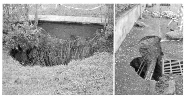
Fig. 2: Erdfall unter der Grenzmauer eines Gartens (Bild links) zum Gehsteig einer Quartierstrasse (Bild rechts). Der Einsturz erfolgte spontan und ohne irgendwelche Vorwarnung durch frühere Vorkommnisse ähnlicher Art in der Region. Der Untergrund besteht aus Elsässer Molasse, die Malmkalken überlagert ist. Als Ursache werden Karsthohlräume im Malm vermutet, die sich über einen längeren Zeitraum gebildet haben.
