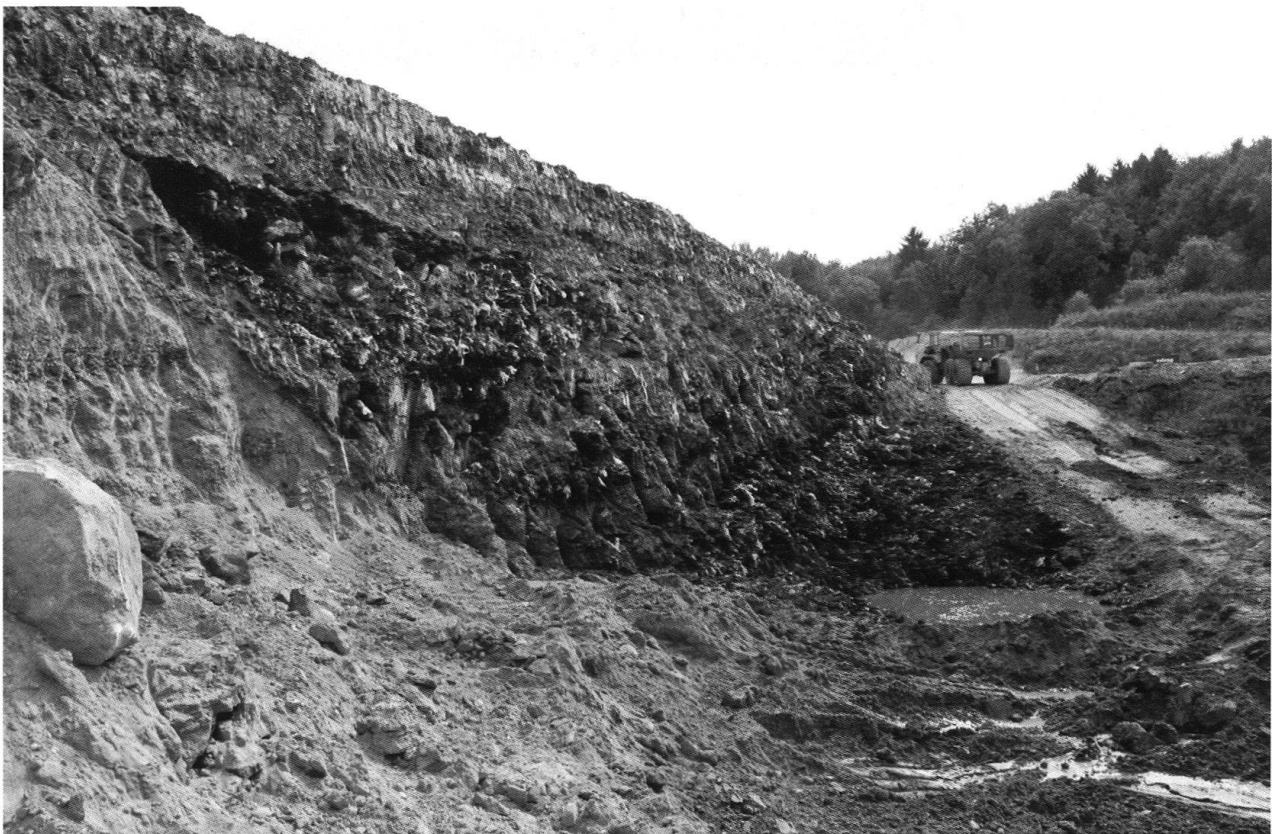
Fig. 3: Grenze zwischen einem der drei Deponiekörper und dem umliegenden Lockergestein.
