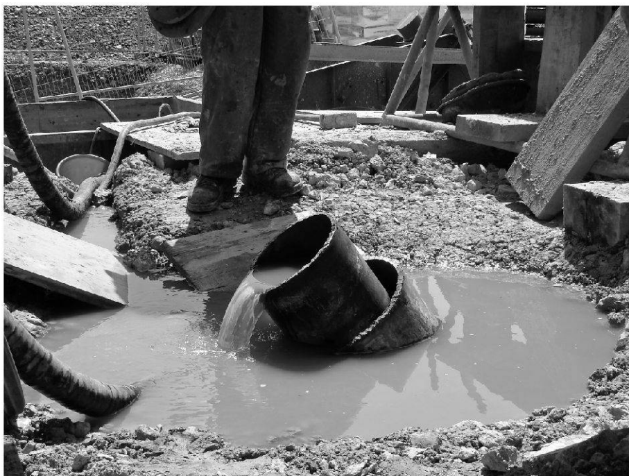
Fig. 8: Venue d'eau artésienne sortant du tubage 9"5/8.
