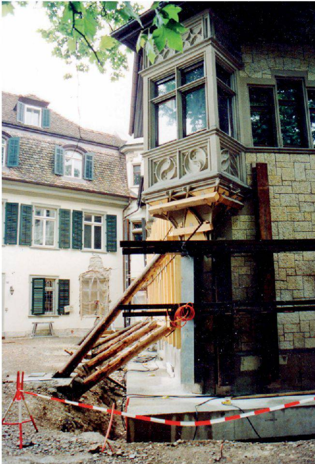
Fig. 5a: Setzungsschäden und erste Sanierungsmassnahmen an einem denkmalgeschützten Haus, Steigstrasse, Schaffhausen (Fotos S. Frank).
