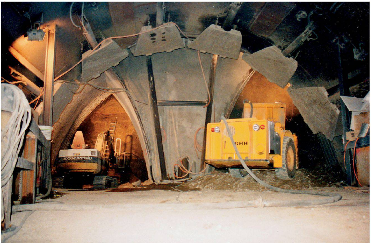
Fig. 4: Fäsenstaubtunnel, Vortrieb Nord, km 16.814: Umstellung Schildvortriebsverfahren [zurückgezogene Brustsicherungskappen am oberen Bildrand] auf Teilausbruchverfahren [3-teiliger Kalottenvortrieb] mit Spritzbetonsicherung (Foto S. Frank, September 1991).
