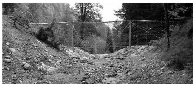
Fig. 2: Filet dynamique de retenue contre les laves torrentielles à Vorder Ritzgraben.
