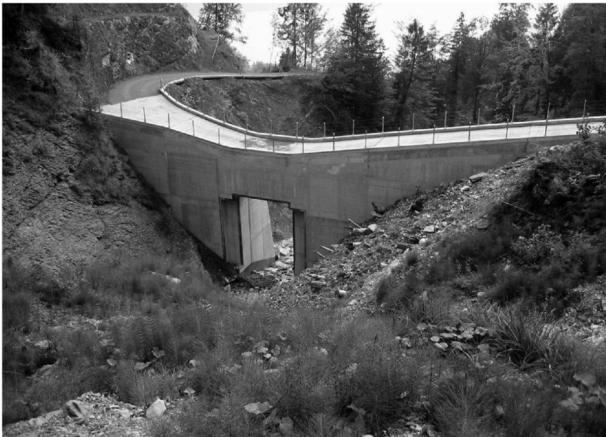
Fig. 1: Barrage filtrant en béton armé à l'aval immédiat de la zone instable à Hinter Ritzgraben.
