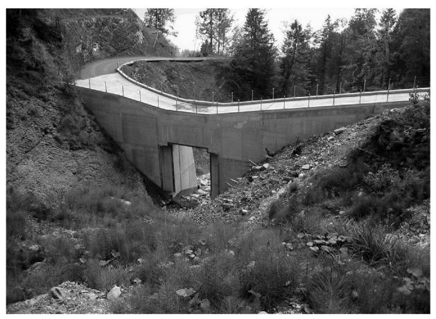
Fig. 1: Barrage filtrant en béton armé à l'aval immédiat de la zone instable à Hinter Ritzgraben.
