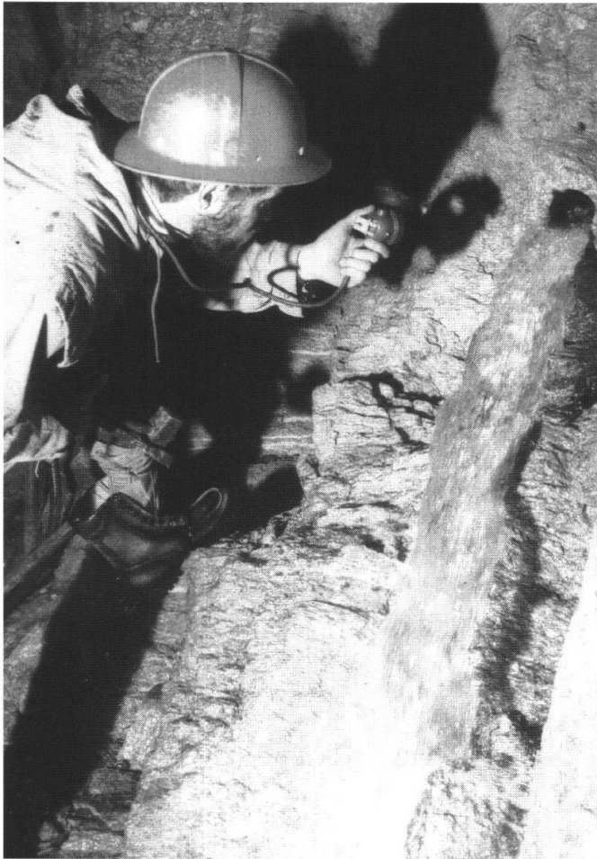
Fig. 9: Trinkwasserbohrung vom Stollen aus (ca. 5.5 l/s).
