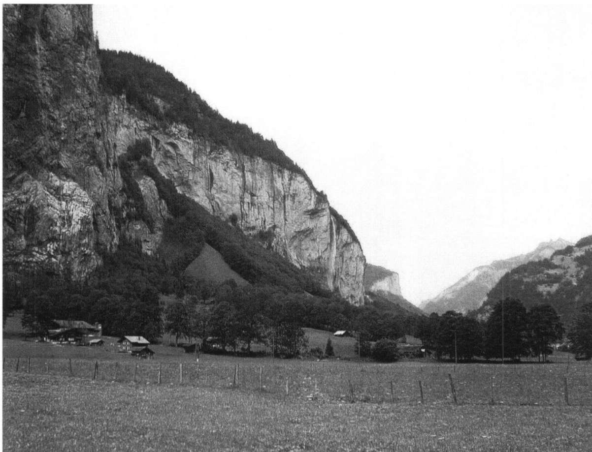
Fig. 13: Der 1889 aufgeschüttete Kegel (Volumen ca. 100'000 \text{ m}^3 ) beim Spissbach (siehe Kasten Seite 32). Rutschungen im oberen Einzugsgebiet des Baches führten zu Murgängen, welche das Erdmaterial zum Talboden transportieren. 1999 begann unmittelbar südlich ein ähnlicher Prozess, allerdings mit geringeren Ausmassen. Die Bewegungen sind auch heute noch, ein Jahr später, im Gange.
