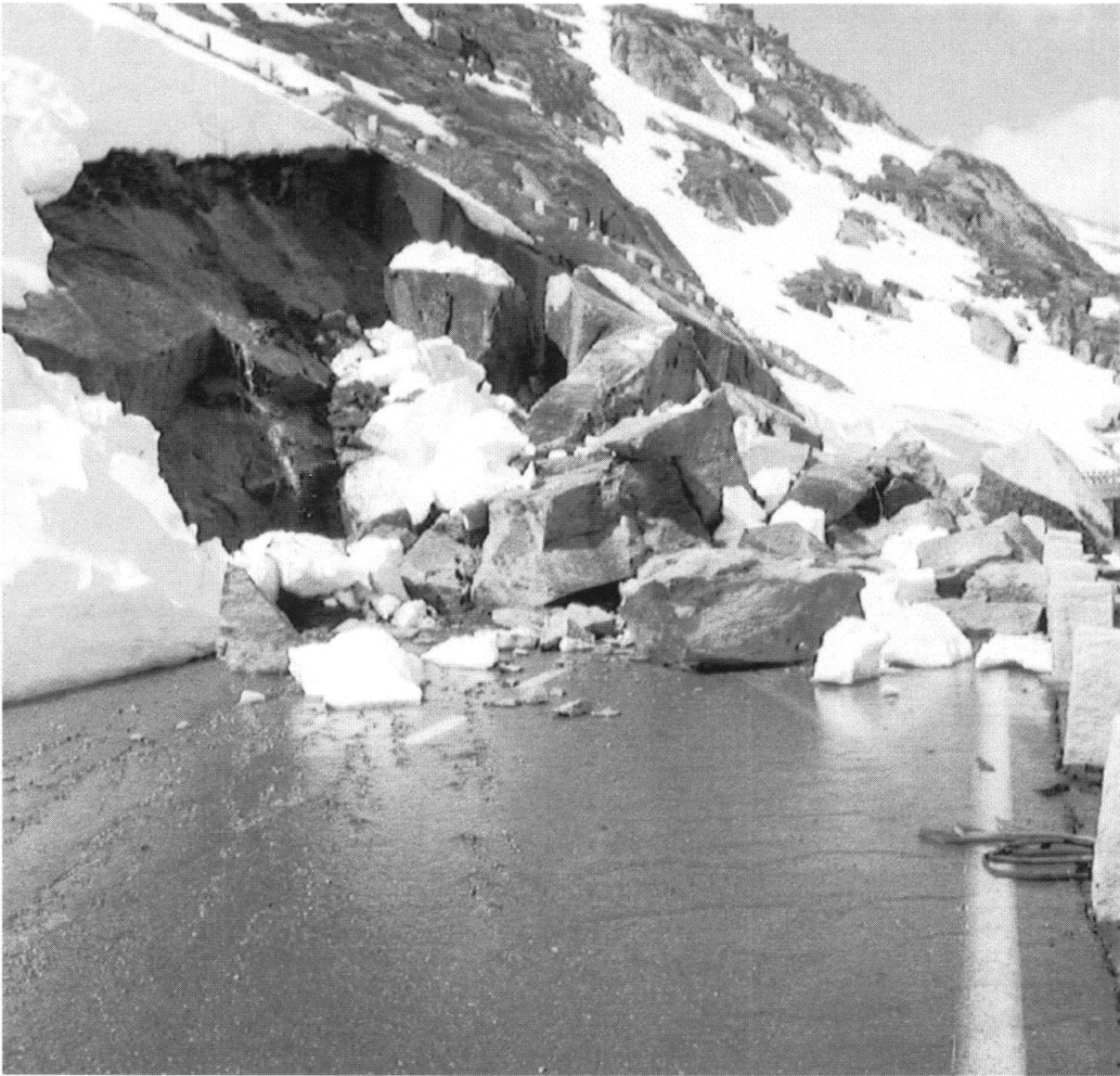
Fig. 12: Abgeglittene Granitplatten an der Grimselpassstrasse.
