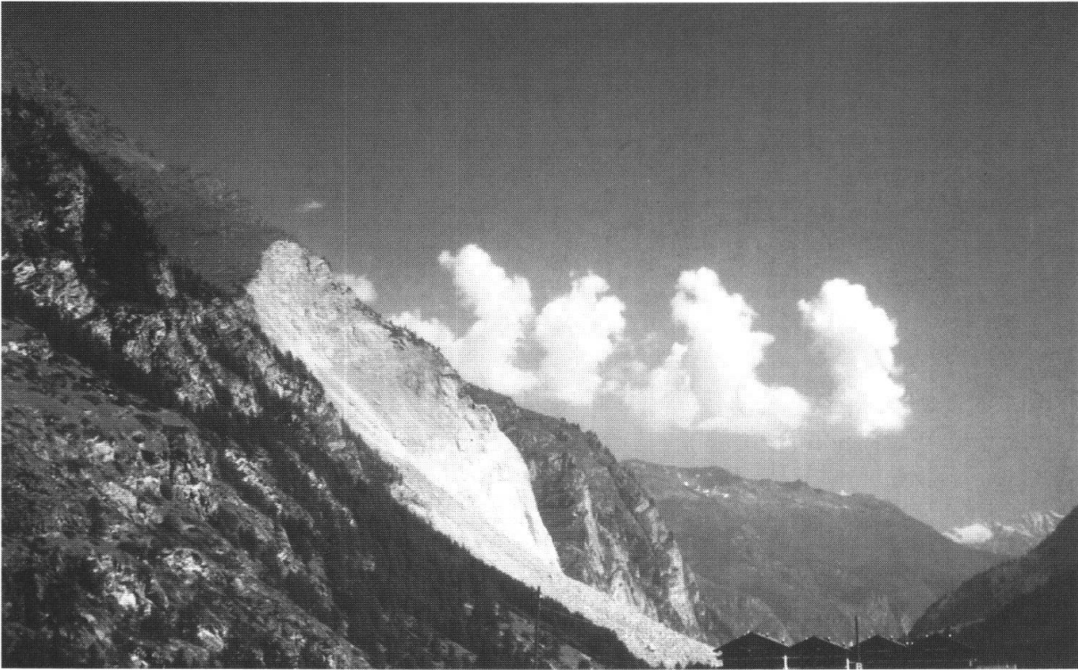
Fig. 4: Felsstürze Randa (VS). Ausbruchnische und Schuttkegel. Das Gesamtvolumen der Felsstürze beträgt 30 Mio m 3 . Da die Abbrüche in kleineren Teilstürzen von <500'000 m 3 erfolgten, ist das Pauschalgefälle entsprechend klein (35°). Die Ereignisse von Randa werden daher richtigerweise nicht als Bergsturz bezeichnet. Foto H.R. Keusen
