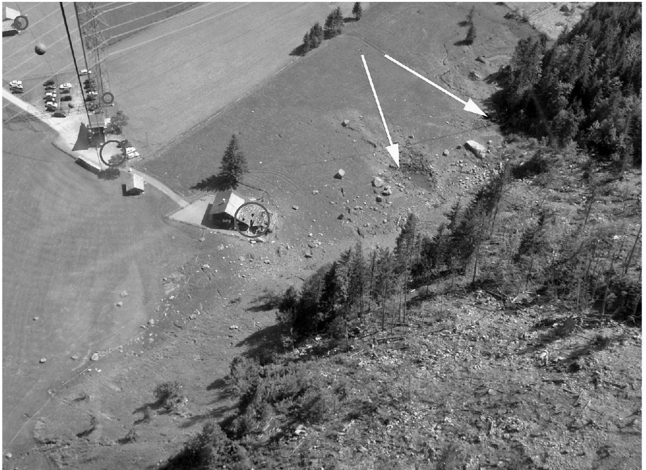
Fig. 2: Aufnahme des Sturzgebietes aus der Seilbahnkabine mit Streufeld der Blöcke, Einschlagtrichter von zwei Grossblöcken (Pfeile), beschädigtem Haus und Talstation der Allmenalpbahn. Kreise = Schäden durch Treffer von Steinen und kleinen Blöcken.
