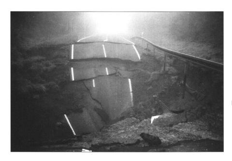
Fig. 9: Nachbruch des Erdfalles auf der B 180 im Oktober 2001 mit vollständiger Zerstörung der Fahrbahn (Foto: Dauterstedt).
