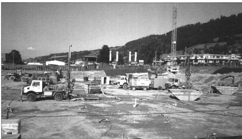
Fig.10: Bohrarbeiten für das Erdwärmesondenfeld des Speichers.
