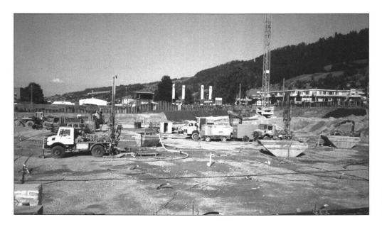
Fig.10: Bohrarbeiten für das Erdwärmesondenfeld des Speichers.
