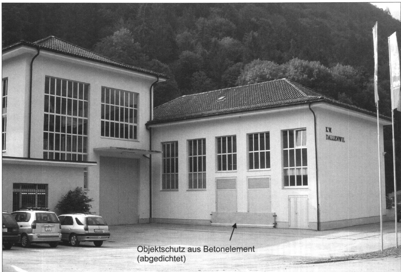
Fig. 6: Wirksamer Objektschutz aus Betonelement mit Abdichtung beim Kraftwerk Dallenwil (Nidwalden).
