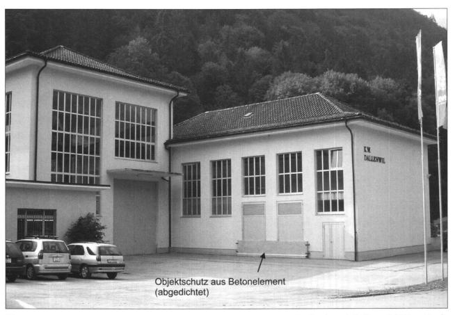
Fig. 6: Wirksamer Objektschutz aus Betonelement mit Abdichtung beim Kraftwerk Dallenwil (Nidwalden).
