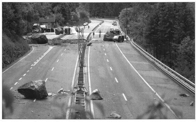
**Fig. 9:** Felssturz Gurtnellen, 31. Mai 2006 (Foto Kantonspolizei Uri). Grossblöcke mit Kubaturen zwischen 6 und 60 m³ erreichten die Autobahn oder stürzten sogar noch über diese hinaus. Daneben lagen viele Splitterblöcke auf der Fahrbahn.
