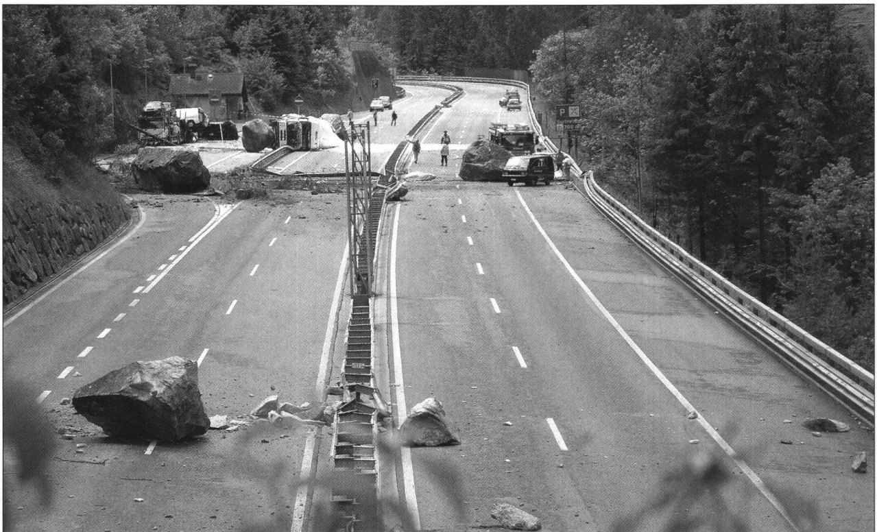
Fig. 9: Felssturz Gurntellen, 31. Mai 2006 (Foto Kantonspolizei Uri). Grossblöcke mit Kubaturen zwischen 6 und 60 m 3 erreichten die Autobahn oder stürzten sogar noch über diese hinaus. Daneben lagen viele Splitterblöcke auf der Fahrbahn.
