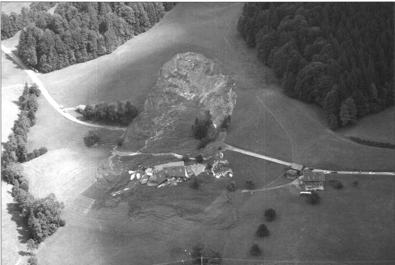
Fig. 2: Die Rutschung Feldweid. Situation am 23. August 2005 (Foto Schweizer Luftwaffe). Die Rutschung zerstörte die Scheune und das Wohnhaus der Liegenschaft Feldweid, die Renggstrasse wurde talwärts geschoben. 2006 brach eine weitere Rutschscholle ab. Sie riss im Wald, seitlich zur Anbruchnische von 2005, rechts oben im Bild, ab.
