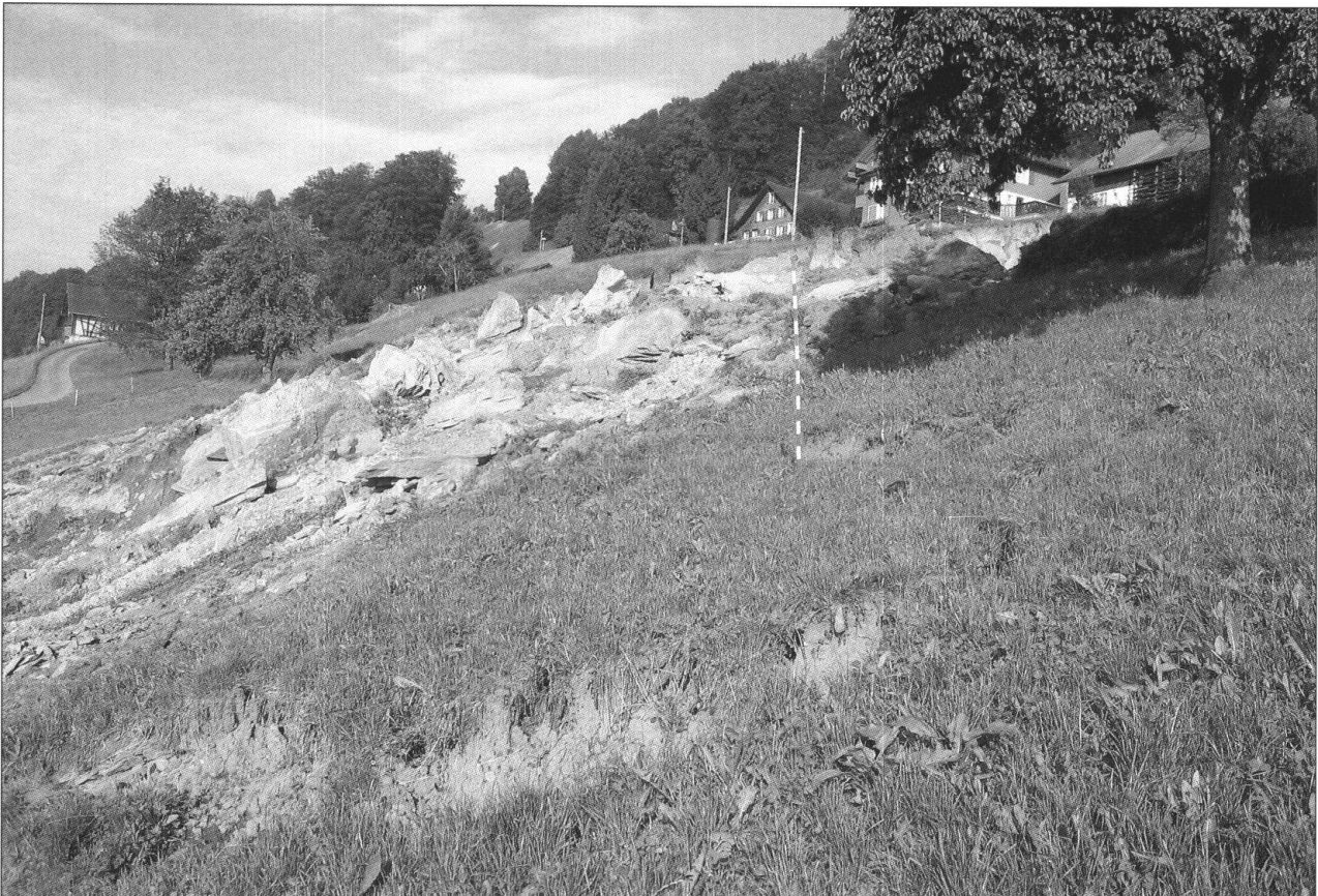
Fig. 6: Hangmure/Felsrutschung Buochli, Ennetbürgen (Ereigniskataster Nidwalden, Foto Oeko-B AG). Die Hangmure erfasste nicht nur Lockergestein, sondern auch Teile der unterliegenden Felsschichten (tertiäre Stadschiefer der helvetischen Bürgenstock-Teildecke).
